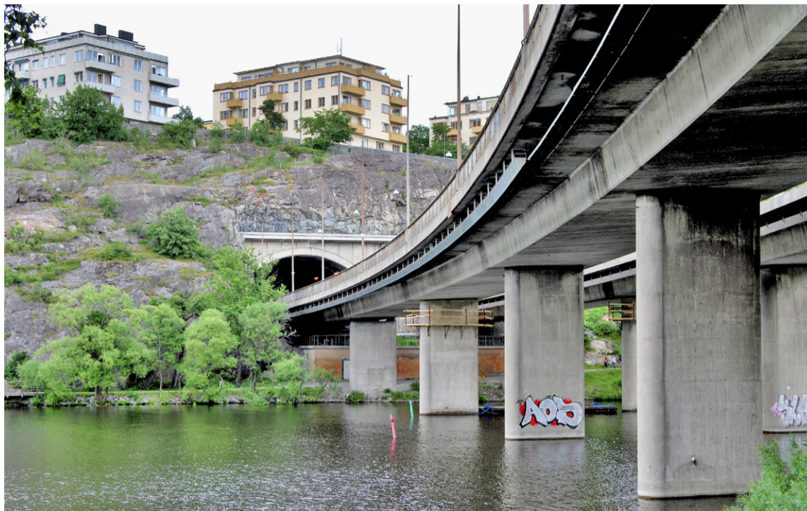
De dubbla brospannen från Lilla Essingen kastar sig in i Fredhällstunneln. Här brusar dygnet runt en aldrig sinande ström av fordon.
